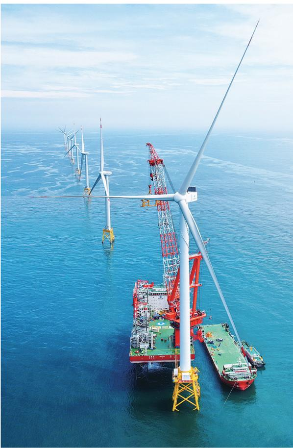
这是16兆瓦超大容量海上风电机组安装完成现场(6月28日摄,无人机照片)。
