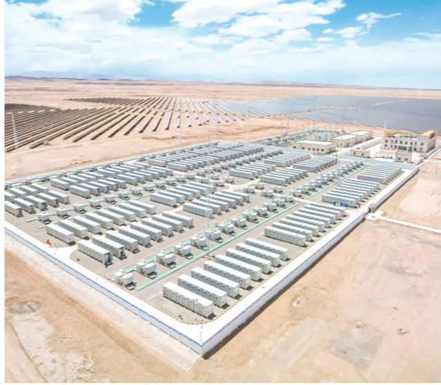
俯瞰电化学储能电站
