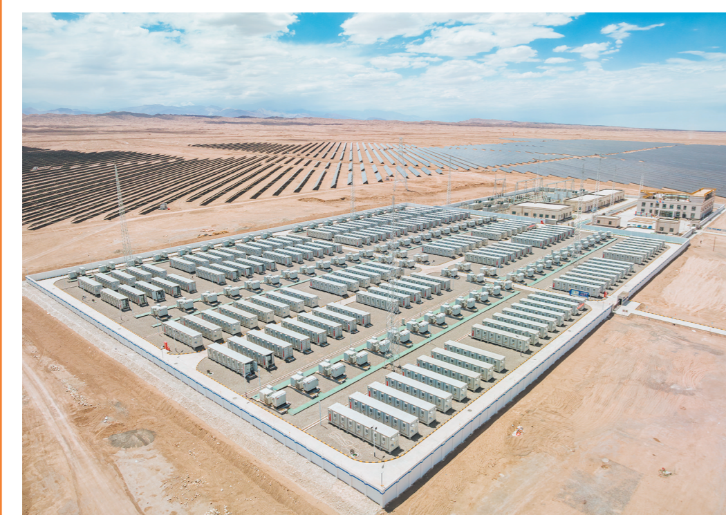
中车株洲所助力国内最大电化学储能电站全容量并网投运。企业供图
