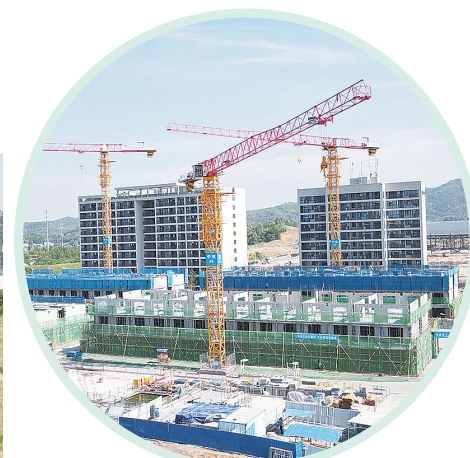
三硅能5GW太阳能电池片项目施工现场。记者/张威 摄
