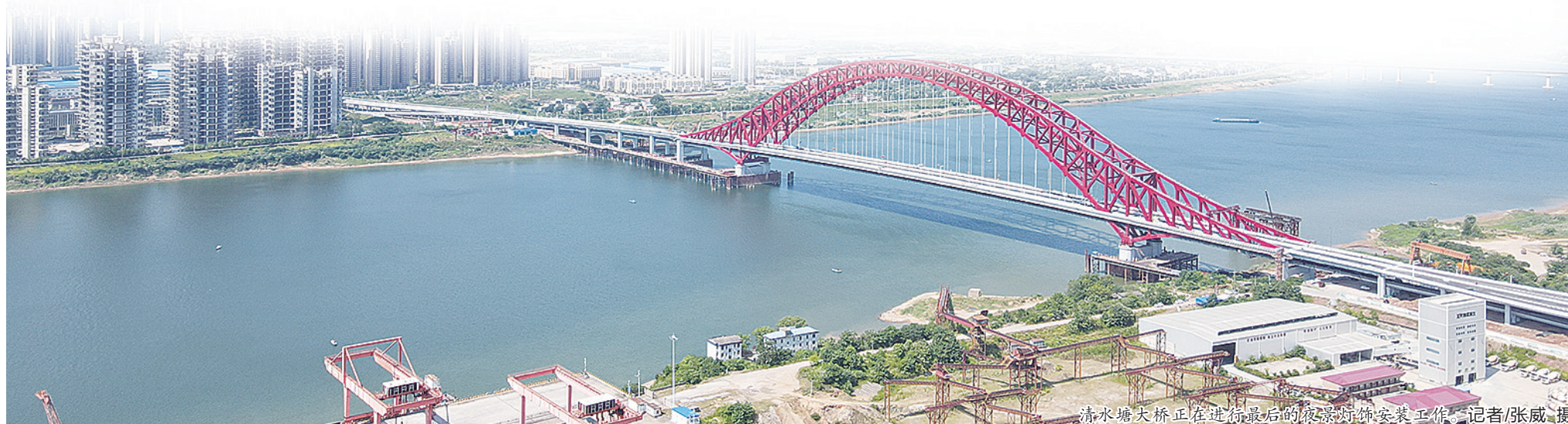
清水塘大桥正在进行最后的塔架安装工作。记者/张威 摄
