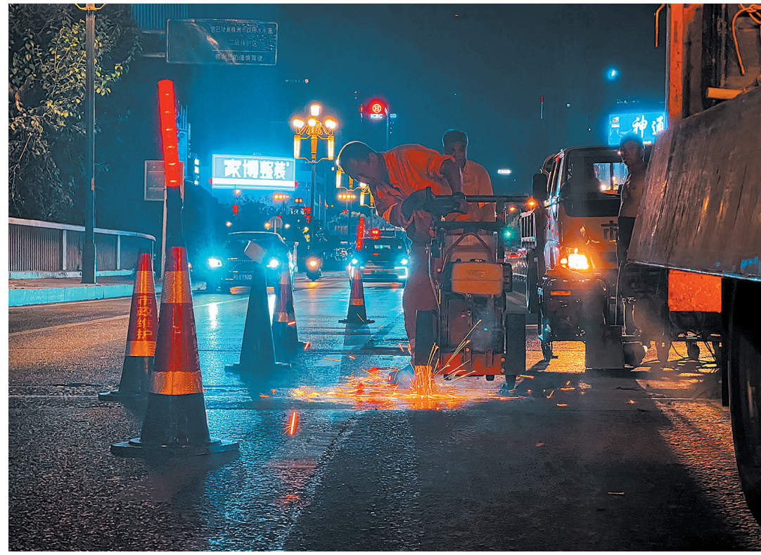
昨日凌晨，为株洲大桥动“手术”疗伤现场 记者/伍靖雯 摄
