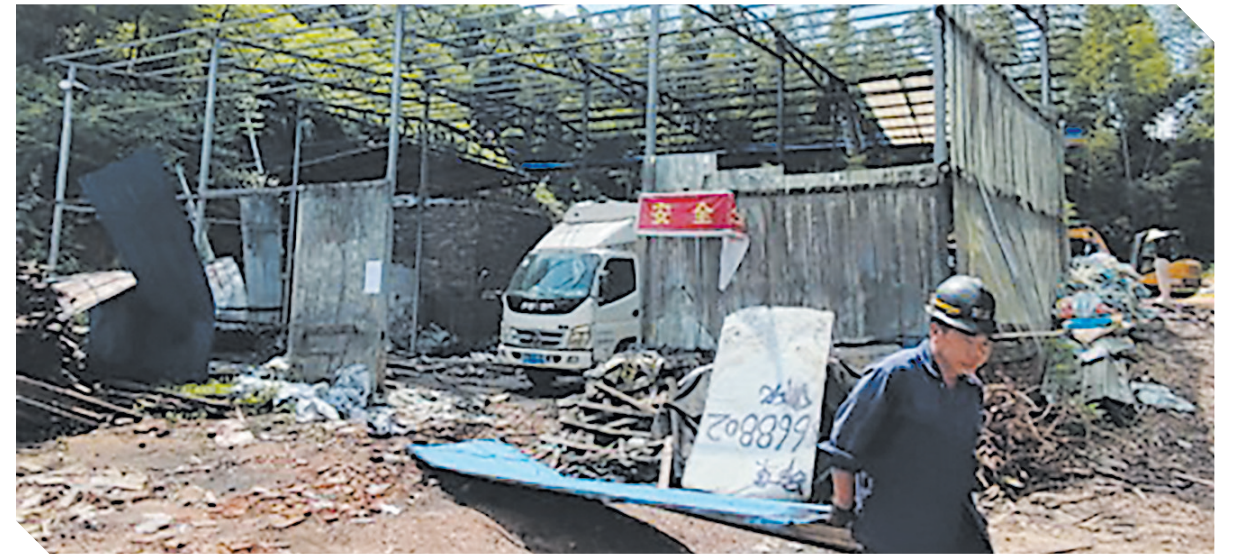
违法占用土地上的建筑已基本拆除。受访单位供图
