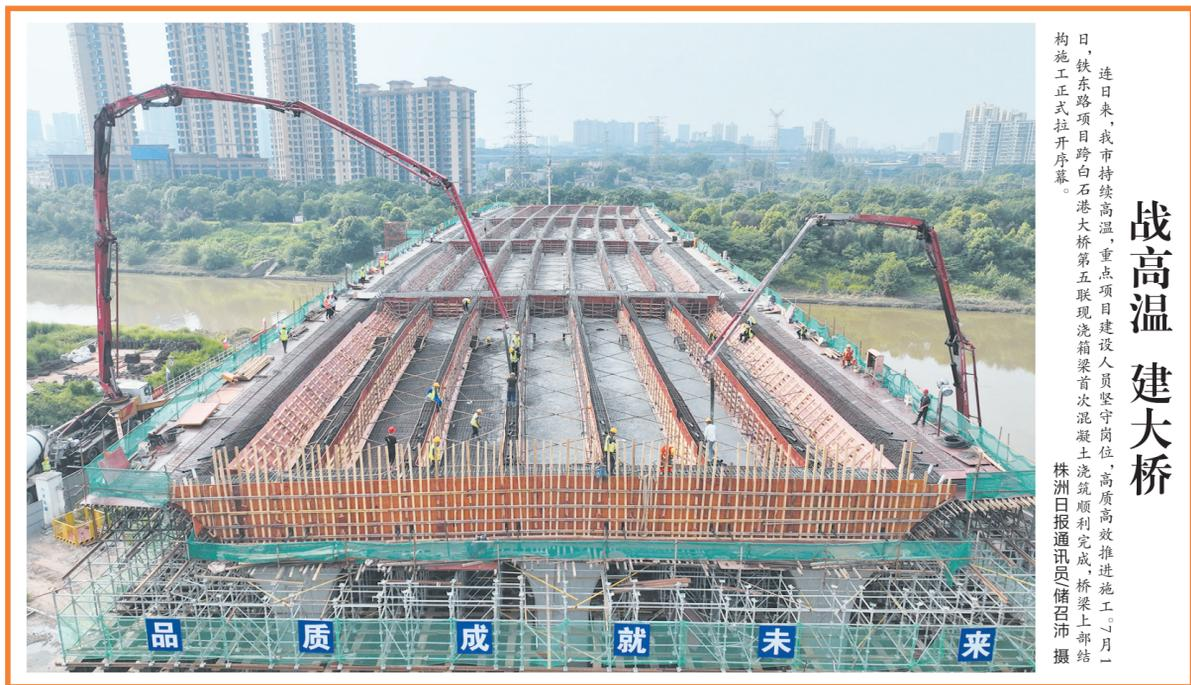
连日来,我市持续高温,重点项目建设人员坚守岗位,高质量推进施工进度,日,铁东项目跨白石港大桥第五联现浇箱梁首次混凝土浇筑顺利完成,桥梁上部结构施工正式拉开序幕。
