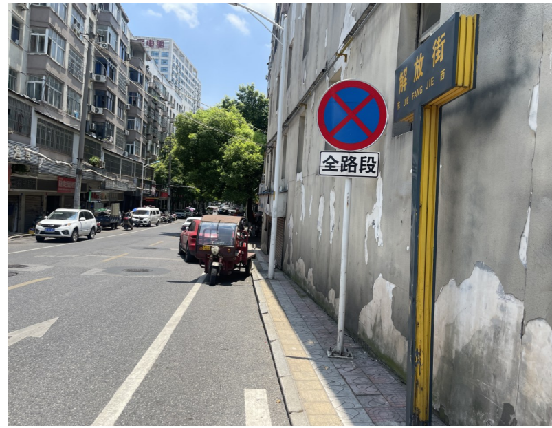
解放街沿线老旧破损的人行道 记者/伍靖雯 摄
