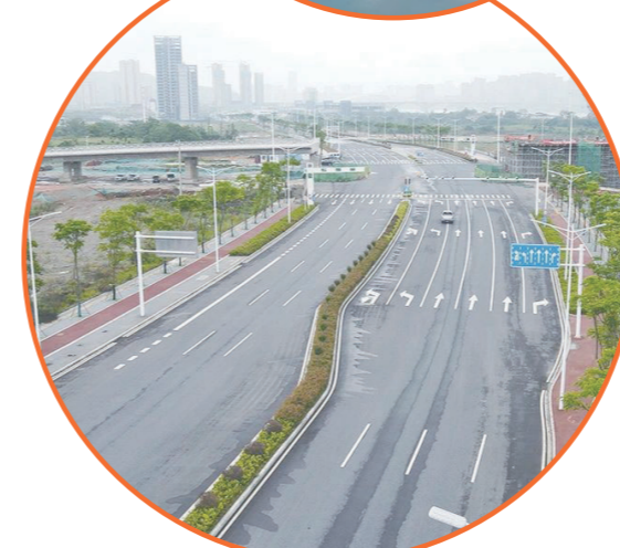
平整宽敞的道路。
