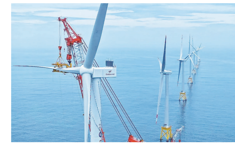
16兆瓦海上风电机组完成吊装。企业供图
