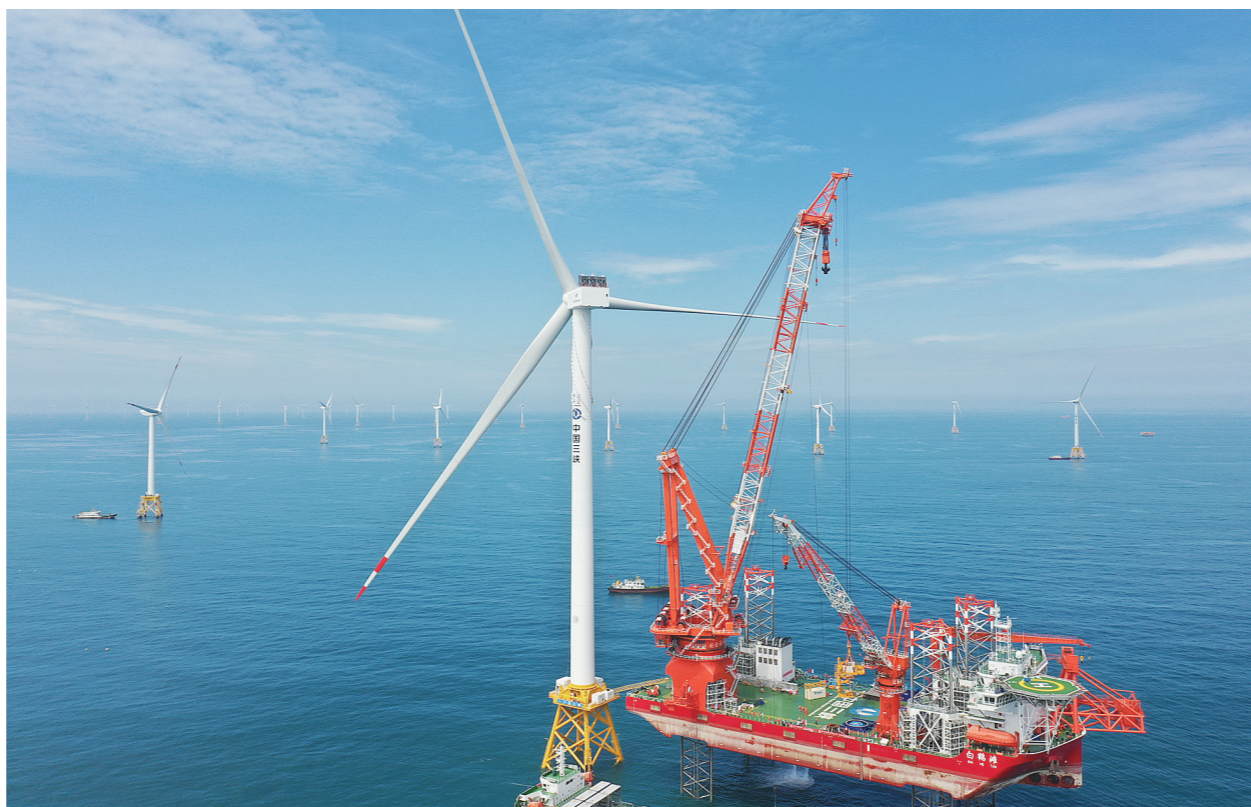
6月28日拍摄的全球首台16兆瓦海上风电机组吊装现场(无人机照片)。新华社记者 林善传 摄
