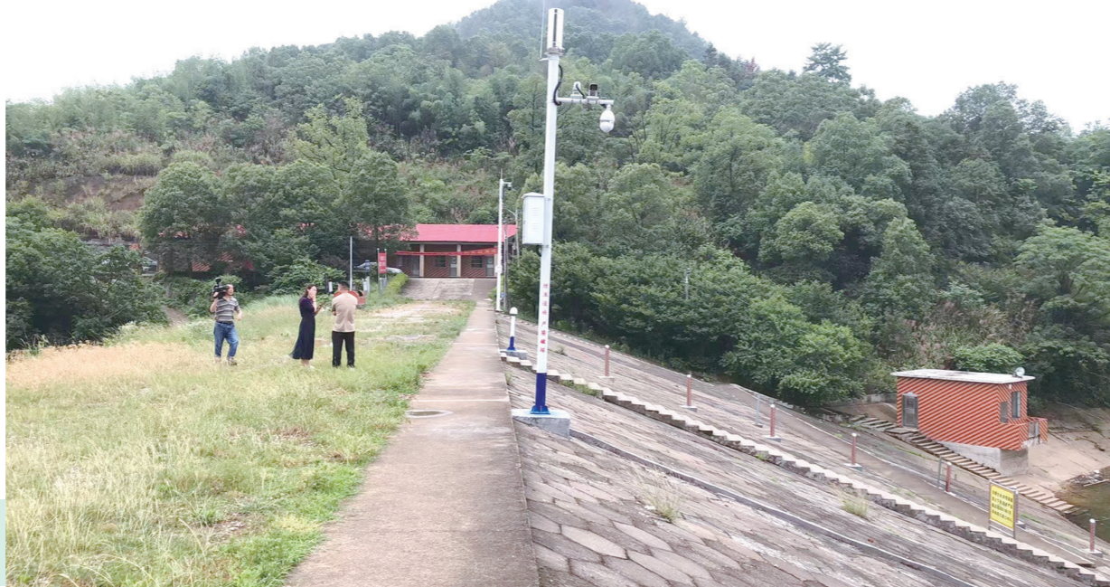
石峰区五一水库安装了智慧监管系统。俞强年 摄
