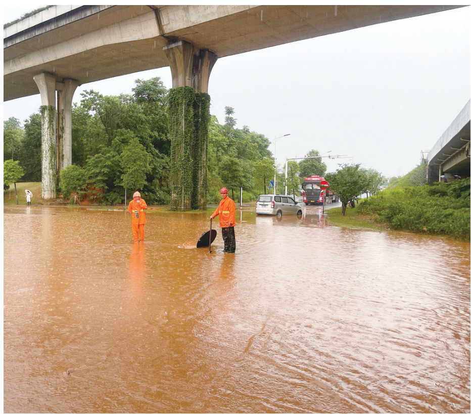
6月8日暴雨期间，王家坪立交桥下出现大面积严重积水 记者/伍靖雯 摄
