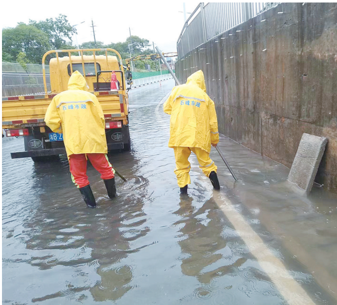
6月22日，石峰城管市政部门在报亭南路沿线处置道路积水。受访部门/供图
