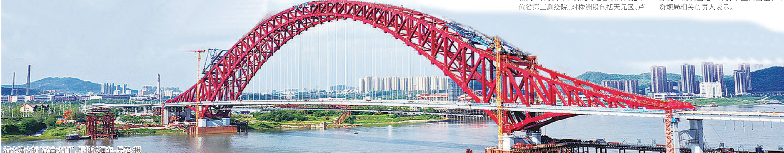
清水塘大桥“浮出水面”,即将试通车。吴楚/摄
