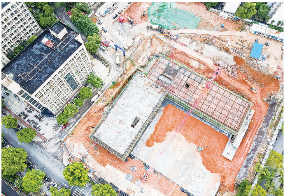
正在施工的中车株机厂前广场改造工程。吴楚/摄
