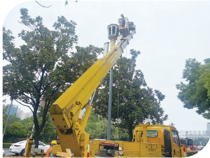
我市开展照明设施大中修工程 记者伍靖雯摄
