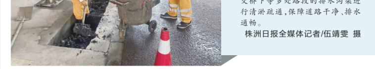
暴雨过后,沉积的淤泥垃圾易堵塞排水口,在再次遭遇强降雨时引发道路积水,影响车辆、行人通行安全。6月10日,市城管局市政工程维护中心养护队冒着炎炎烈日,加班加点对王家坪立交桥下等多处路段的排水沟渠进行清淤疏通,保障道路干净、排水通畅。
