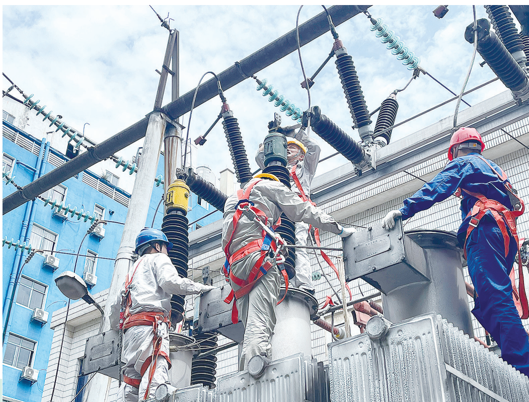
变电站改造现场。通讯员供图
