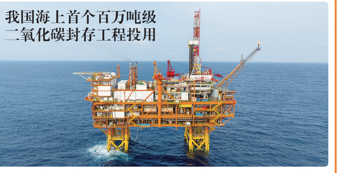
我国海上首个百万吨级二氧化碳封存工程投用 6月1日，在距离深圳西南约200公里的恩平15-1原油钻采平台，油田开发伴生的二氧化碳被捕获、分离、加压至气液混合的超临界状态，回注至距平台3公里远、在海床约800米底下的“穹顶”式地质构造中，实现长期稳定封存。我国海上首个百万吨级二氧化碳封存工程投用，每年封存容量达30万吨，总计超150万吨，相当于植树近1400万棵，这标志着我国成功掌握海上二氧化碳捕集、处理、注入、封存和监测的全套技术和装备体系，实现了我国海上二氧化碳封存领域从无到有的重要突破。 图为6月1日拍摄的中国海油恩平15-1原油钻采平台(无人机照片)。 新华社记者 毛思倩 摄
