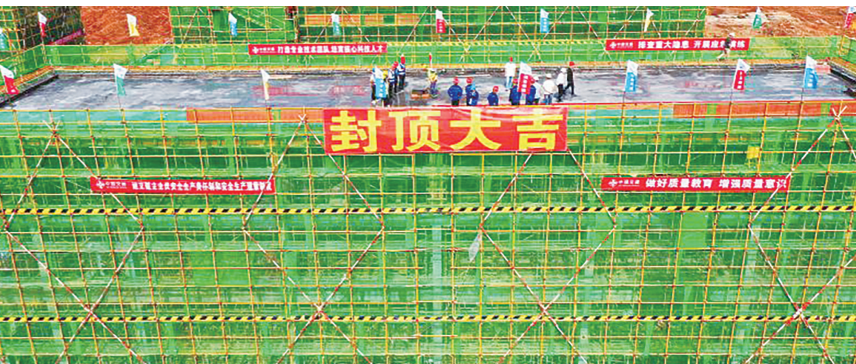
图为封顶现场。记者/李卉 摄
