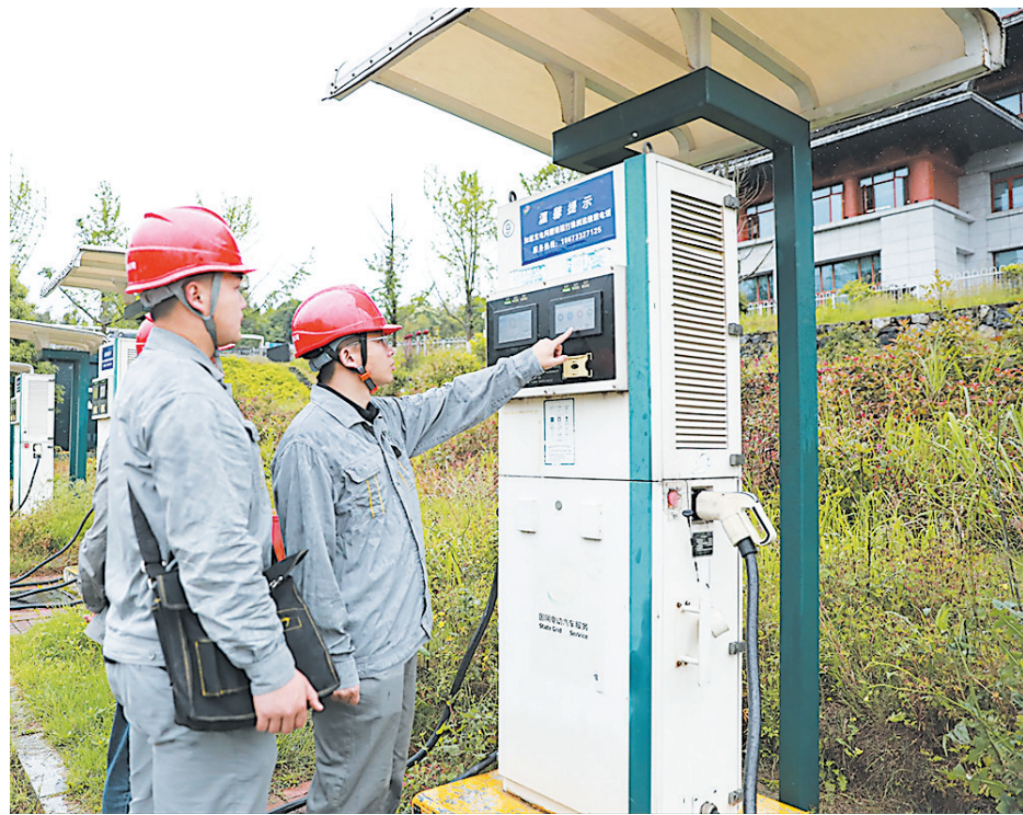
国网攸县供电公司员工正在对景区电动汽车充电桩进行充电设施巡护与检查。 通讯员供图
