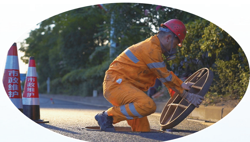
红旗立交东环路辅道排水管网淤堵，此次将进行疏通改造。 记者/伍静雯 摄
