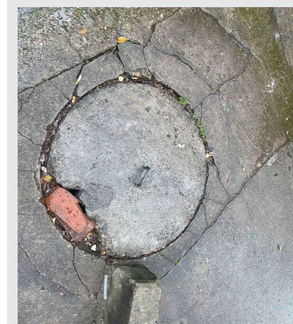
▲部分老旧小区窨井盖管护标准不高,仍然存在安全隐患。 记者/伍靖雯 摄
