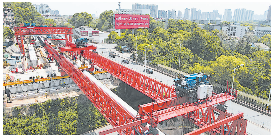
响田大桥拓宽改造施工现场。通讯员 供图
