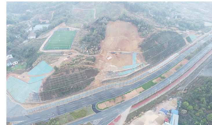
田心大道古滑坡地质灾害治理工程现场。受访者供图
