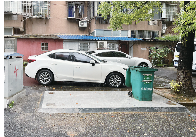
▲神塘冲小区42栋居民楼旁,垃圾分类亭已停止施工。 记者/刘平 摄
