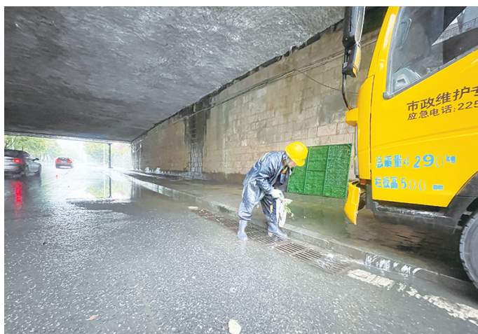
红旗南路跨石宋桥下,市政队员曹新文将堵住雨水篦子的垃圾捡起。 记者/伍靖雯 摄
