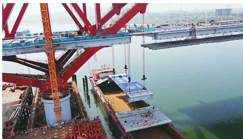
▲吊装主梁块体过程。通讯员供图
