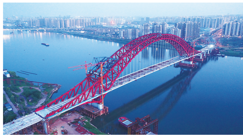
▲4月15日,清水塘大桥主桥合龙贯通。通讯员供图
