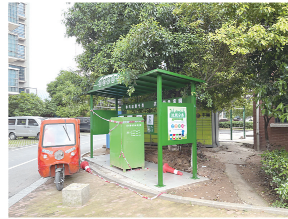
▲新建的垃圾分类亭靠近居民楼。记者/刘平 摄
