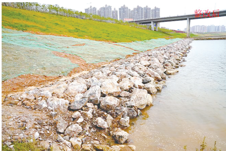
株洲湘江河西段(珠江南路—建宁大桥)岸线整改后。通讯员供图
