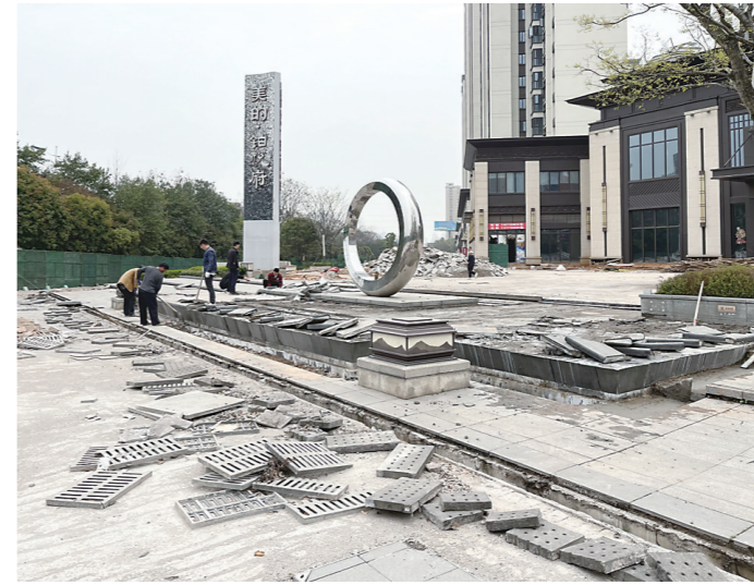
▲售楼部前坪大范围施工。记者/刘平 摄
