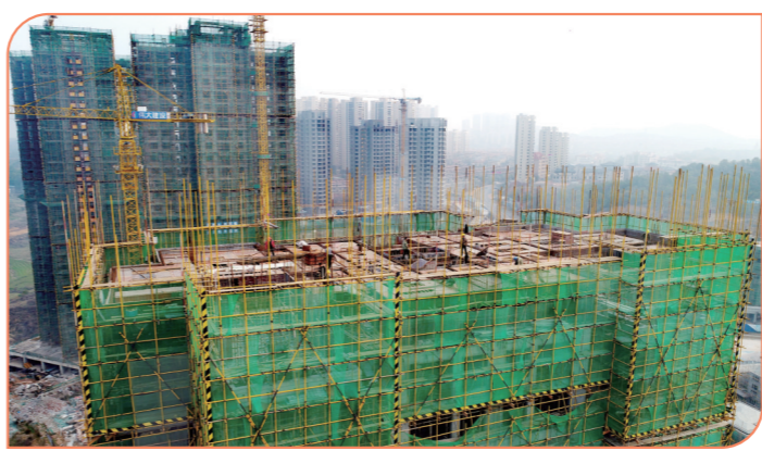
▲第五代建筑示范区项目工地正在如火如荼的进行。
