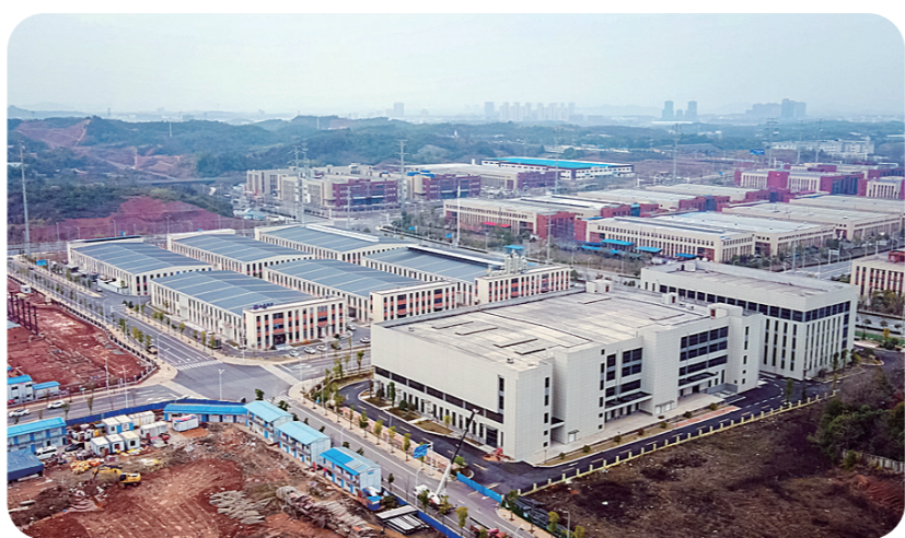
天易科技城自主创业园2.5期厂房及配套基础设施建设项目现场。
