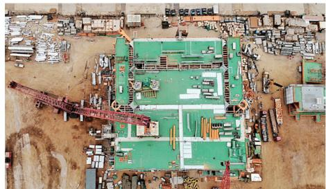
这是正在建造中的渤中19-6凝析气田一期CEPA(中心处理平台)组块。近日,渤海油田渤中19-6凝析气田一期开发项目CE-PA(中心处理平台)组块在青岛完成封顶工作,标志着渤海湾首个千亿方大气田上部平台陆地建造取得重要进展,为气田按期完工投产奠定坚实基础。
