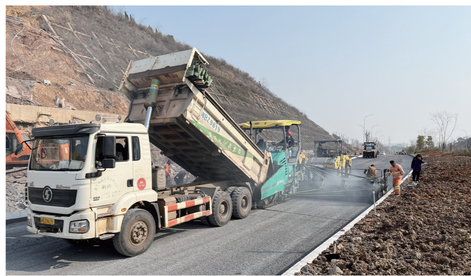
▲受损道路得到修复,重新铺上了柏油。 记者刘平摄
