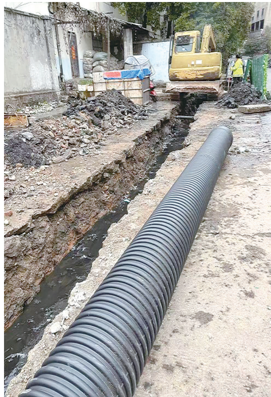
管道改造中。通讯员供图
