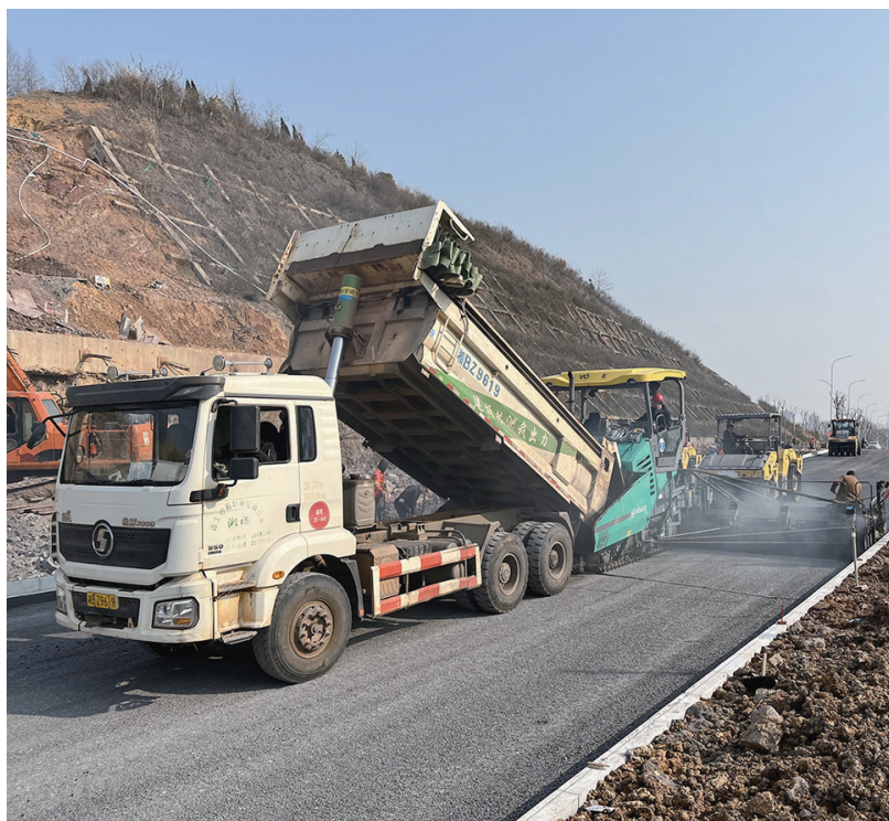
田心大道九牛山路段,受损道路修复,重新铺上了柏油。 记者/刘平摄
