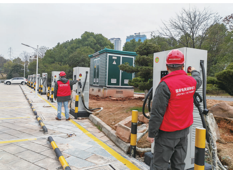
位于市体育中心的综合型电动汽车充电桩。记者高晓燕摄
