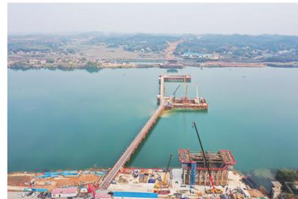
2月19日,醴娄高速四标株洲湘江特大桥主桥11号、14号墩已经进入上部结构施工,12号墩完成水下承台的混凝土浇筑。13号墩已完成围堰的施工,正在进行水下开挖作业。
