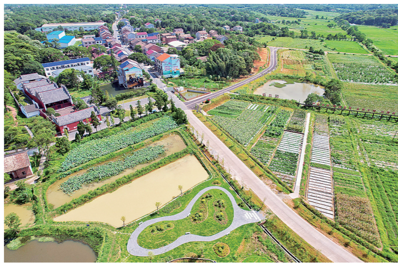
俯瞰东富村,东富寺屋场紧邻东富寺,与其一路之隔的是百菜园。
