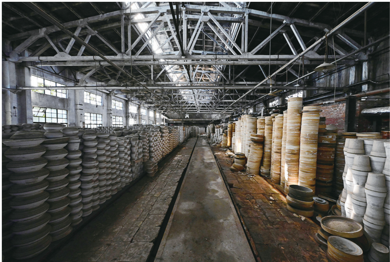
群力瓷厂旧址，生产车间里还保留着当时的模样。 通讯员/黄永强 摄
