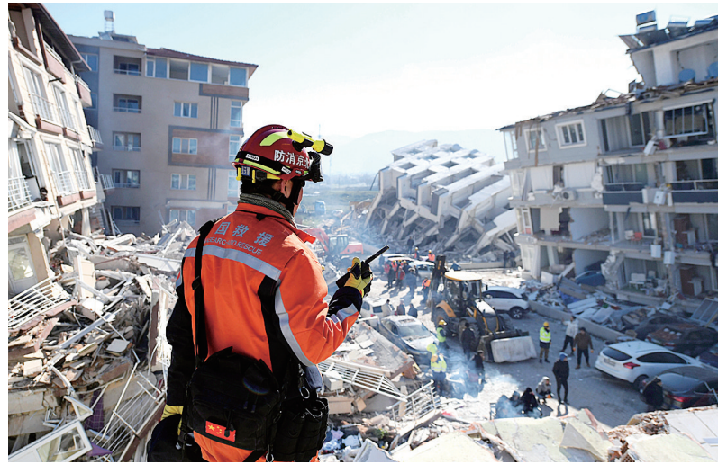
2月9日,中国救援队队员在土耳其哈塔伊省安塔基亚市的受损建筑上开展救援工作。新华社记者沙达提摄
