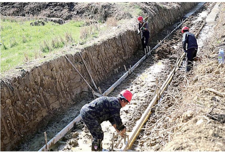
金华村高标准农田建设项目施工现场。通讯员 供图
