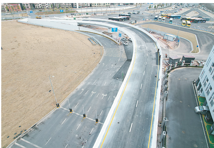
株洲火车站东广场落客平台上下匝道。株洲日报全媒体记者/吴楚 摄
