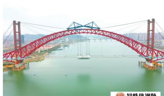
1月16日,清水塘大桥开始进入桥面主梁吊装阶段。主梁整体分为28段组块,目前已完成3段吊装和南北引桥箱梁混凝土浇筑工作。(株洲晚报融媒体中心记者/张威 摄影报道)
