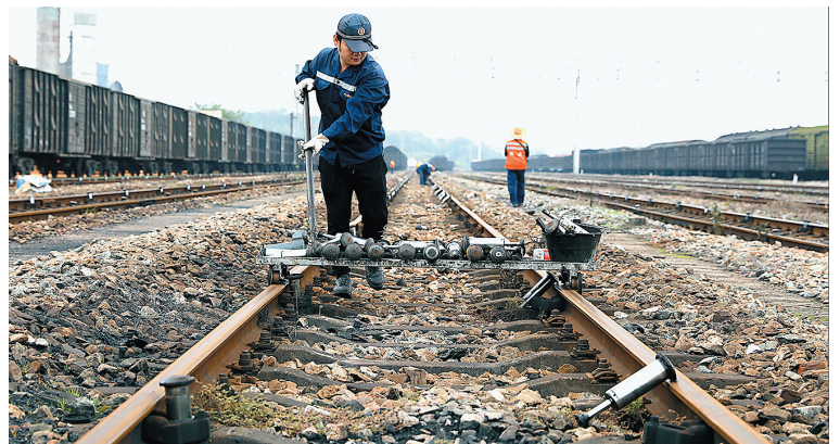
杨南正在检查减速顶。通讯员/吴源强 摄
