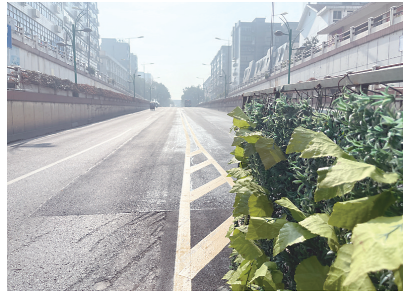
白石港立交桥沿线崭新的沥青路面下,刚刚进行了一场“大手术”。 记者伍靖雯摄
