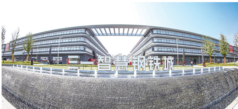
三一智慧钢铁城项目。项目单位供图
