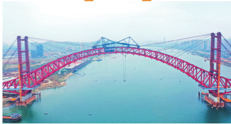
建设中的清水塘大桥。项目单位供图
