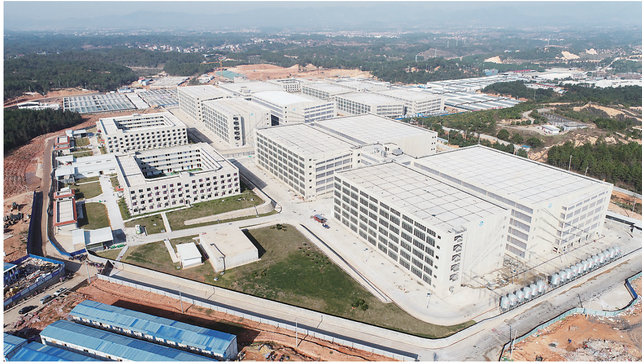
▲唐人神楼房养猪项目。(资料图片)
