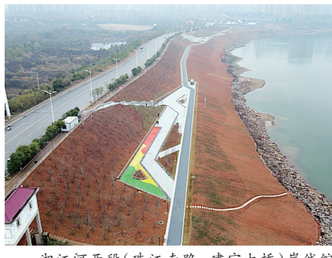
湘江河西段(珠江南路-建宁大桥)岸线综合治理项目竣工 吴楚/供图
